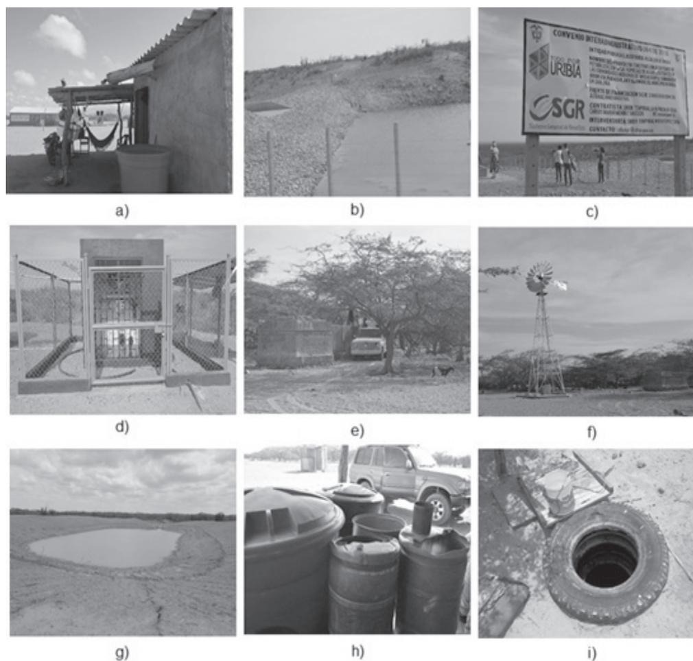
**Figura 4.** Sistemas de abastecimiento de agua: a) Captación de agua lluvia; b) y c) Represa; d) Planta desalinizadora; e) y f) Molino de viento y tanque alberca de almacenamiento de agua de pozo; g) Jagüey; h) Tanques de almacenamiento de agua; i) Pozo artesanal. Fuente: Daza (2018).
