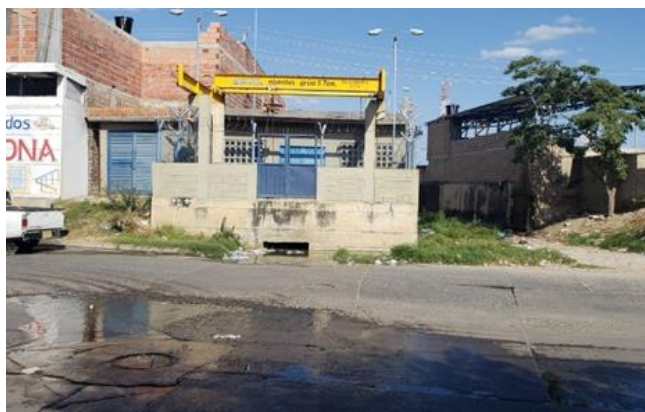
Figura 12. Estación carrera 7h calle 19
