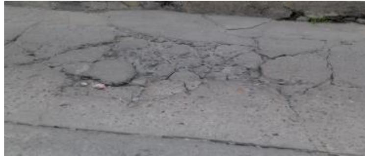
**Tabla 12.** Detalle del estado e intervención del pavimento rígido. Tramo comprendido en la carrera 4 entre calle 2 y calle 7.
