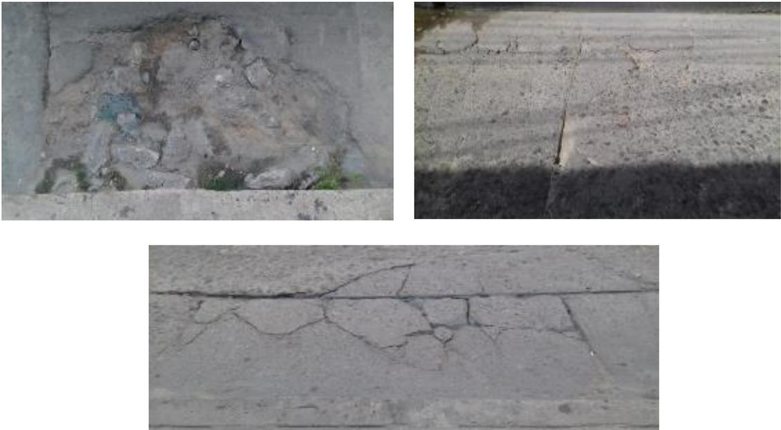
**Tabla 15.** Detalle del estado e intervención del pavimento rígido. Tramo comprendido en la carrera 7 entre calle 2 y calle 7.
