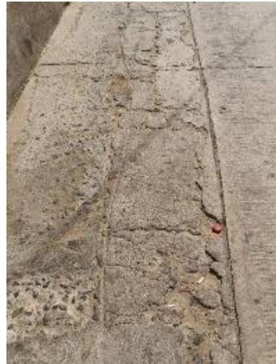
**Tabla 4.** Detalle del estado e intervención del pavimento rígido. Tramo comprendido en la calle 3B entre la carrera 1C y la carrera 6.
