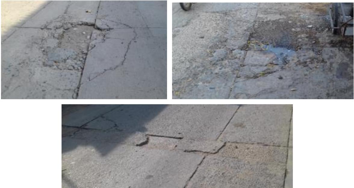
**Tabla 16.** Detalle del estado e intervención del pavimento rígido. Tramo comprendido en la carrera 8 entre calle 3 y calle 7.
