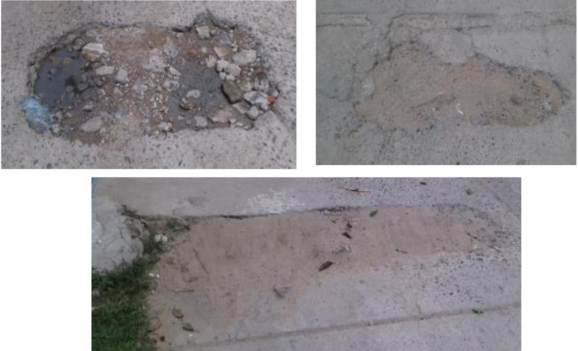
**Tabla 10.** Detalle del estado e intervención del pavimento rígido. Tramo comprendido en la carrera 2 entre calle 2 y calle 7.
