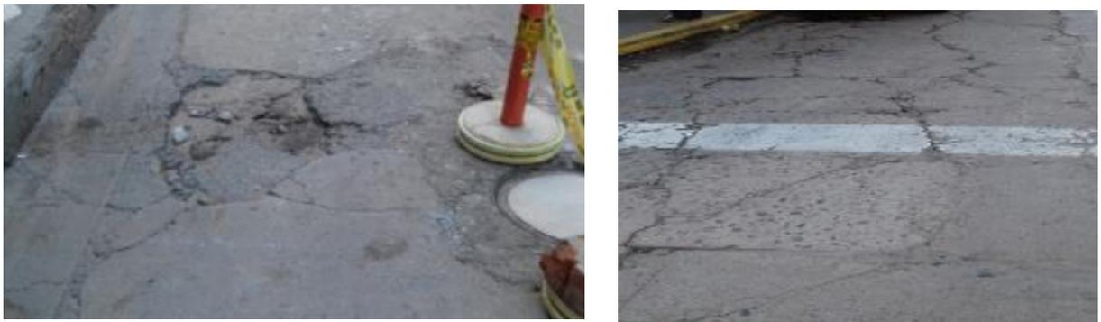
Tabla 17. Detalle del estado e intervención del pavimento rígido. Tramo comprendido en la carrera 9 entre calle 2 y calle 7.
