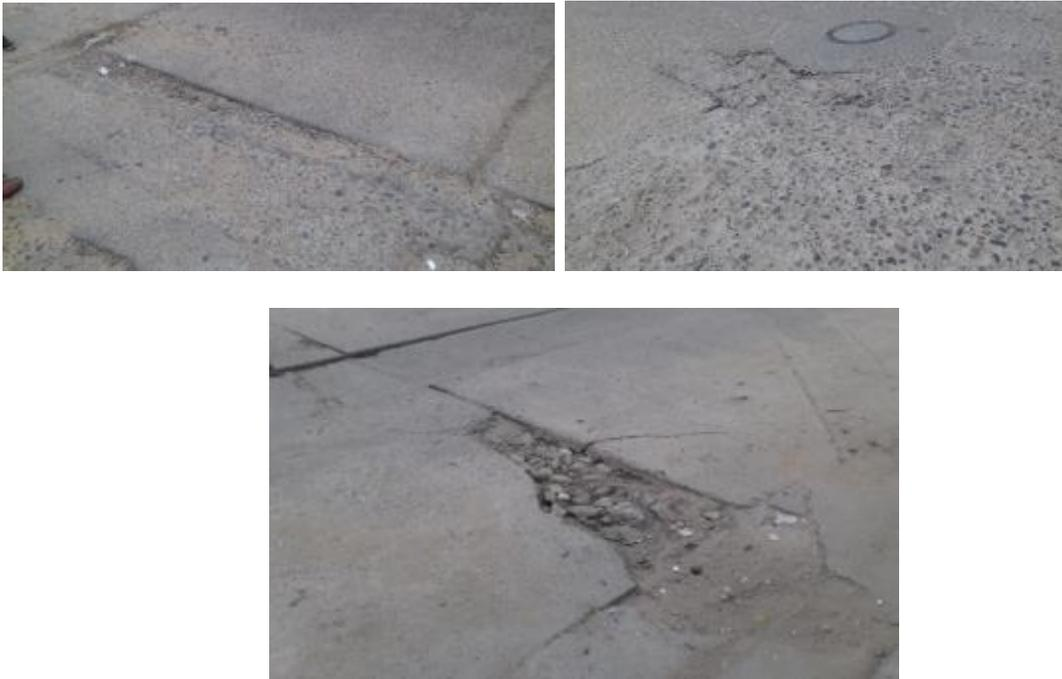
**Tabla 14.** Detalle del estado e intervención del pavimento rígido. Tramo comprendido en la carrera 6 entre calle 2 y calle 7.
